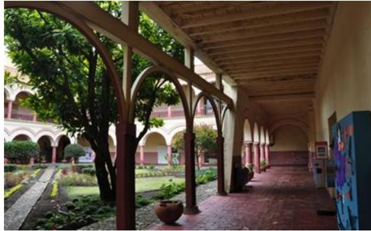
Fig. 19. Detalle arcadas metálicas [Fuente: autor]
